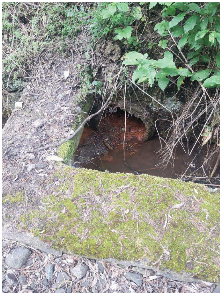
Foto č.6 – zanesené potrubí místní vodoteče u silničního mostu
